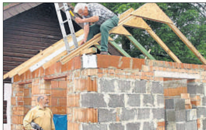
Bald fertig: Die barrierefreie Dusche im Mengerinhäuser Walmebad. Foto: nh
